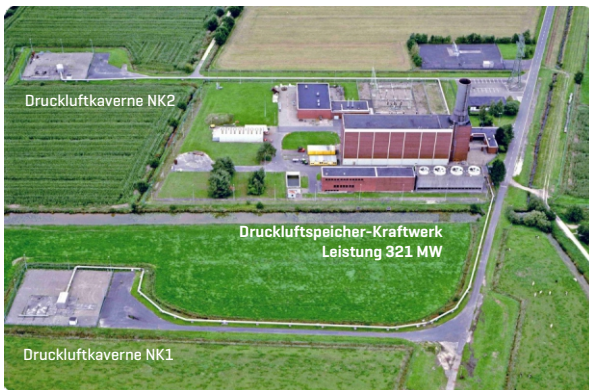
Das weltweit erste Druckluftspeicherkraftwerk in Huntefisch bei Oldenburg
